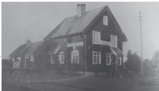
Bilden utlånad av en av våra läsare.
